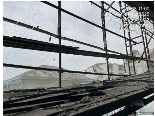
รูปที่ 40 ติดตั้งตะแกรงป้องกันวัสดุตกหล่น โดยรอบอาคาร
