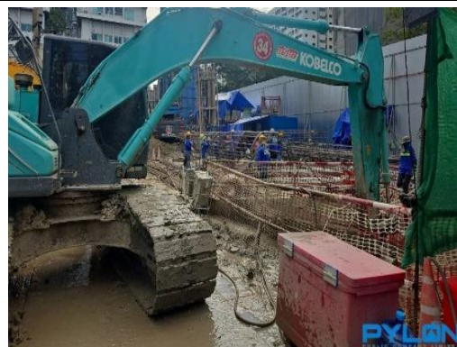
รูปที่ 27 ขุดลอกตะกอนบ่อดักตะกอน
